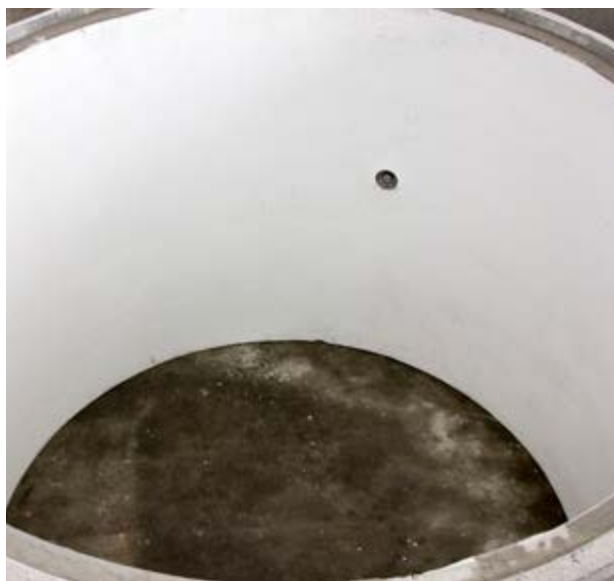
FIG. 13 2300 Diameter Manhole Riser
