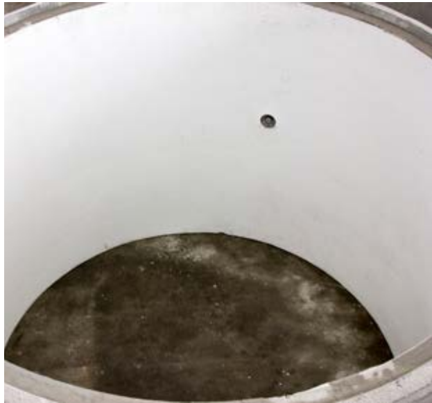
FIG. 13 2300 Diameter Manhole Riser
