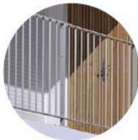
Fin Metal Balustrades
