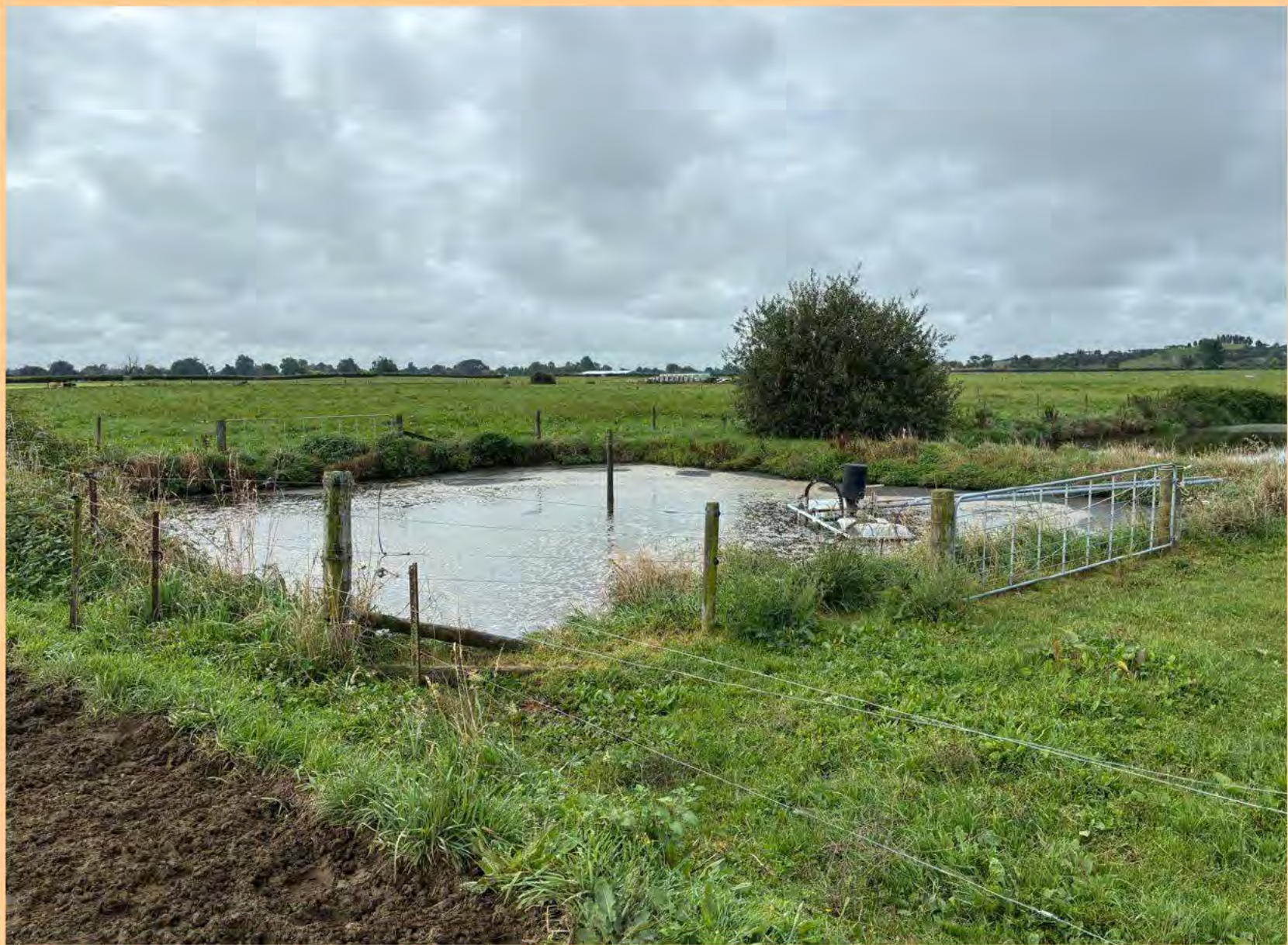
08 Duncan Farm: Effluent pond
