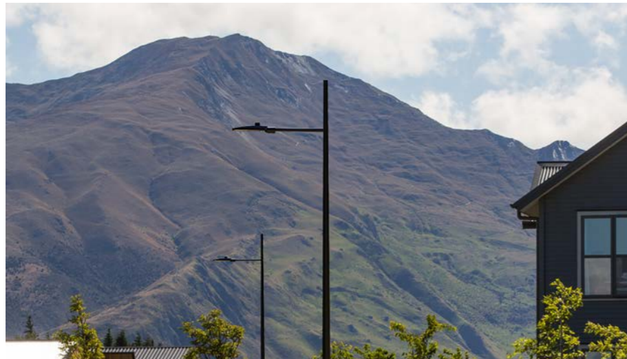
D1 Street light: Milford Column - Nox luminare
