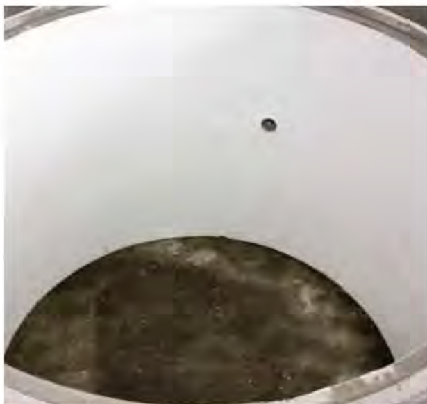
FIG. 13 2300 Diameter Manhole Riser
